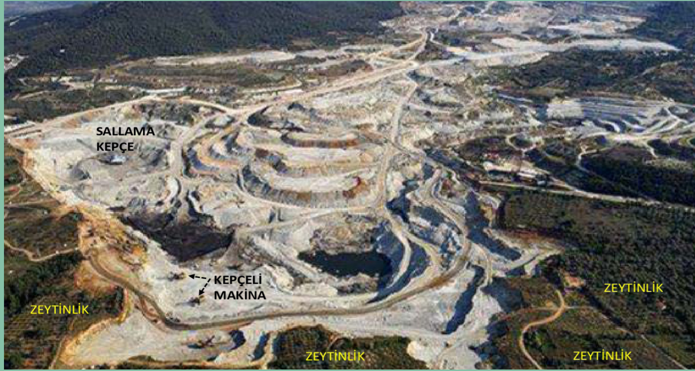
RESİM 8. KÖMÜR YATAĞI ÜSTÜNDEKİ SERT KİRÇ TAŞINI GEVŞETMEK İÇİN YAPILAN PATLATMALAR DEPREM ETKİSİ YAPMAKTADIR
